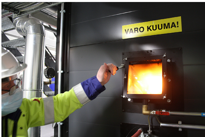
↑ Maksimiteholla pellettikattila käyttää lähes tonnin pellettiä tunnis- sa.
