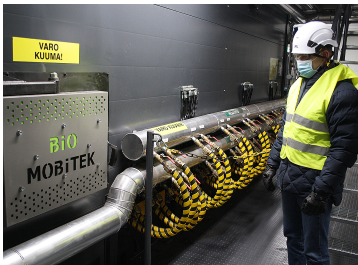
↑ "Lämpölaitos mitoitettiin niin, että verkon energiankäyttö voi vielä kasvaa parikymmentä prosenttia", valottaa Heikki Hapuli.
