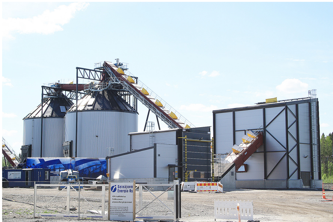
↑ Polttoaineen vastaanotto ja käsittely-yksikkö on lähes valmis.
